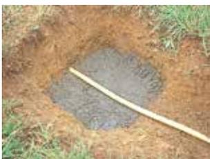
Mettre à nu l'ancienne gaine d'adduction. Sous la gaine, réaliser une assise béton réglée en fonction du niveau des sols finis.
