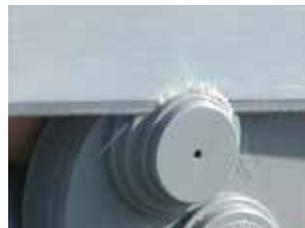
Découper le bouchon réducteur côté privé au Ø extérieur des gaines utilisées.
