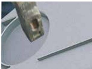
Préparer les emboîtures à utiliser (Ø 100) en dégagant les opercules au marteau.
