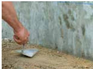
**1** En fonction du niveau des évacuations et du sol fini, établir une base en sable damé ou béton maigre.
