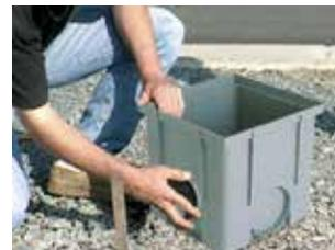
Le mettre en place dans son emboîture par l'extérieur ; l'autre restera en attente. Puis mettre le regard en place dans la fouille.
