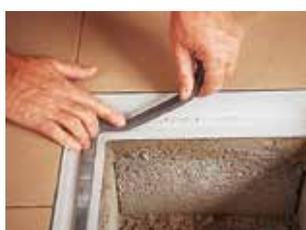
Après séchage complet, poser le joint d'étanchéité.
