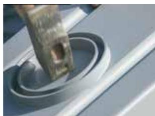
Préparer les emboîtures à utiliser (Ø 100) en dégageant les opercules au marteau.
