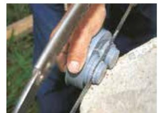
Découper le bouchon réducteur au diamètre extérieur de la gaine nouvelle.
