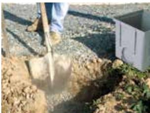
En limite de propriété, préparer en fond de tranchée un lit de sable damé ou de béton maigre réglé en fonction du niveau des sols finis.
