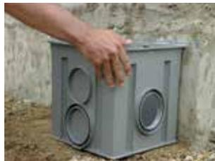
**3** Mettre en place le regard dans l'axe de la descente E.P. Éventuellement le surmonter d'une ou plusieurs réhausse.
