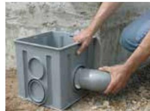
**4** Raccorder les entrées éventuelles et sorties. On peut parfaire l'étanchéité par un joint de mastic silicone.
