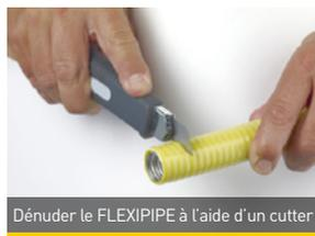
Dénuder le FLEXIPIPE à l'aide d'un cutter
